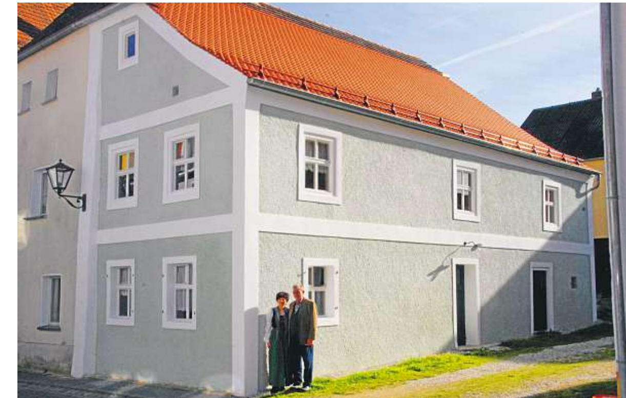
Elfriede und Ewald Altenbuchner haben die Sanierung des Dachstuhls und der Außenfassade des Ackerbürgerhauses abgeschlossen.
